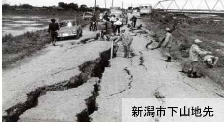
S39.新潟地震による被害状況(左岸1k付近)
