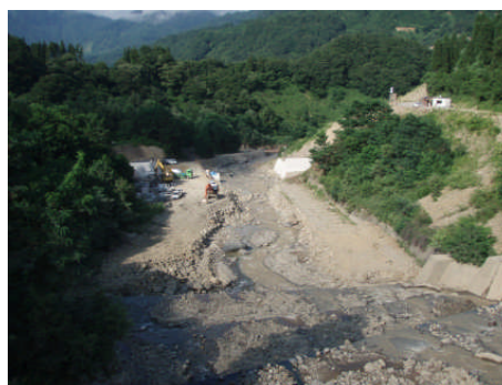
浦川下流6号砂防えん堤より下流を望む (平成21年8月撮影)
