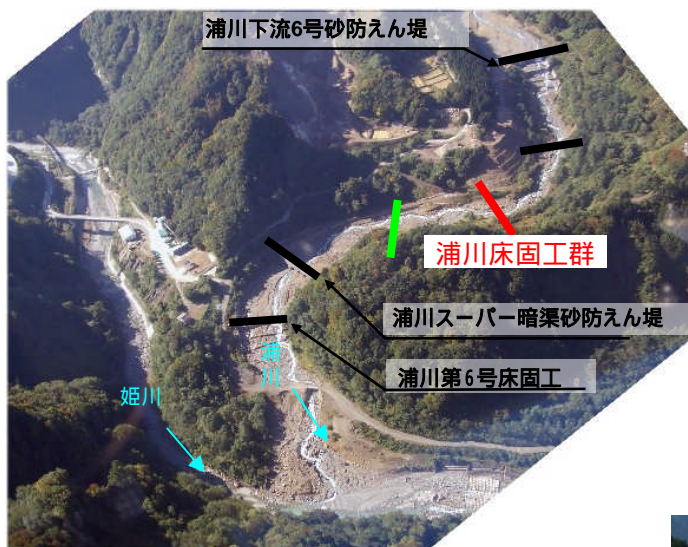
浦川床固工群全景
