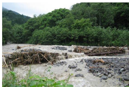
平成18年7月出水後の流木捕捉状況 (しのぶ砂防えん堤上流)
