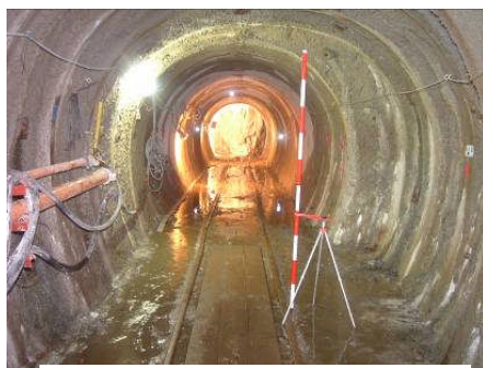
現在施工中の北部排水トンネル
