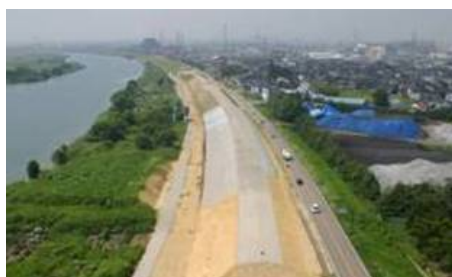
築堤（弱小堤対策）の整備状況
