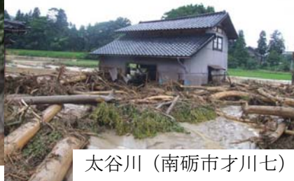
流木による下流域の被害状況
