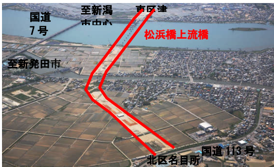
国道113号 松浜橋上流橋（直轄：新潟県）
