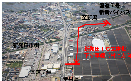
国道7号 新発田IC立体化（直轄：新潟県）
