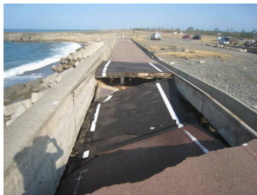
片山津工区篠原地先 (平成19年11月撮影)
