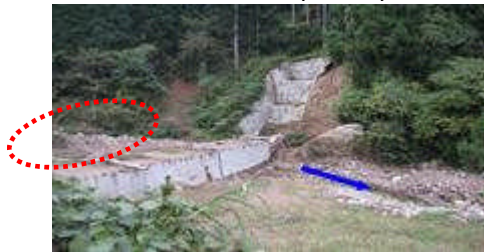
下流砂防えん堤(施工中) 土石流捕捉状況(H20.7)
