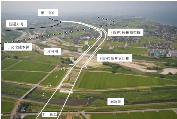
一般国道8号 入善黒部バイパス(富山県)
