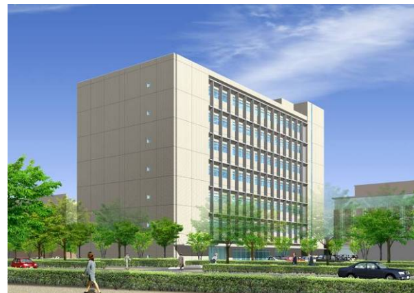
長岡地方合同庁舎(防災拠点)（新潟県）
