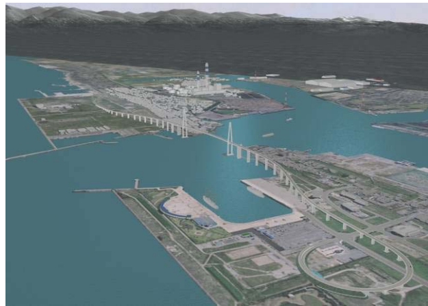
臨港道路(富山新港東西線)(富山県)
