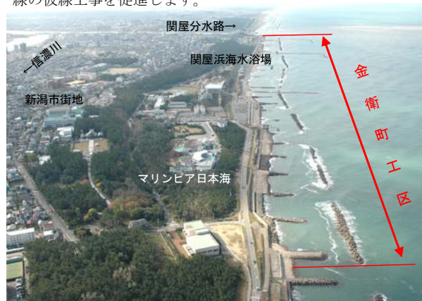
新潟海岸(金衛町工区)海岸保全施設整備事業(新潟県)
