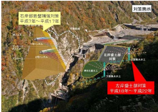
白岩砂防えん堤（富山県）
