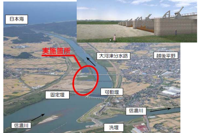
大河津可動堰改築事業（新潟県）
