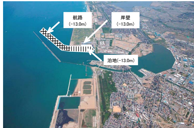
金沢港多目的国際ターミナル(石川県)
