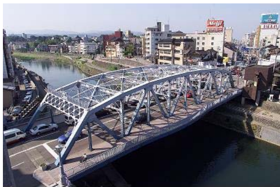
犀川大橋全景
