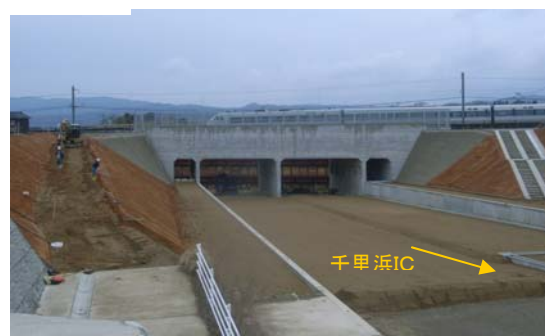
工事促進中の JR 七尾線横断部
