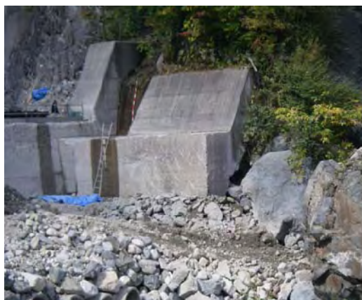
河床低下により護岸背面が空洞化
