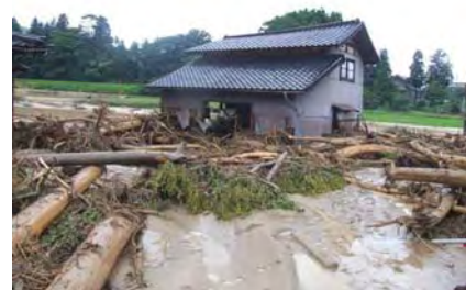
流木による下流域(太谷川) の被害状況
