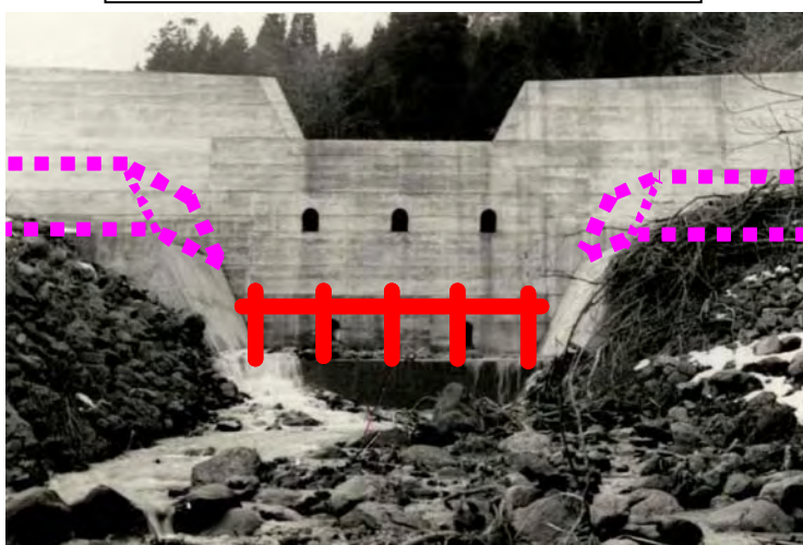
既設砂防えん堤流木止工設置（イメージ）
