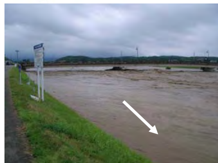
平成20年7月28日出水状況 (小矢部川津沢大橋付近)
