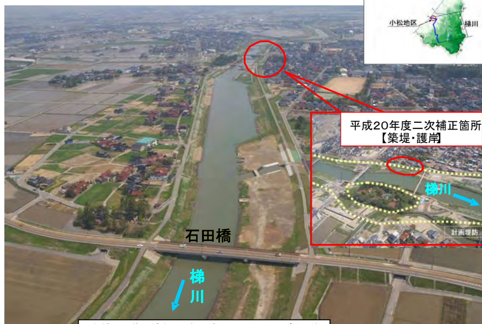
改修の進む梯川（平成 20 年 4 月撮影）
