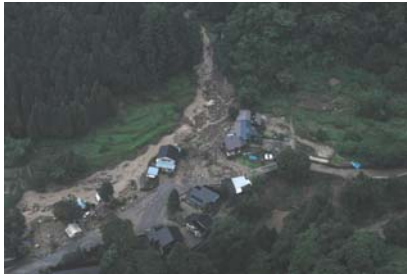
板ヶ谷川板ヶ谷地区（石川県） 平成20年7月28日に発生した土石流の発生を受け、河道に残存した不安定土砂による土砂災害から下流域を守るための砂防えん堤の整備を促進します。
