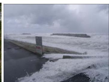
下新川海岸生地先（富山県） 平成20年2月24日に富山県東部地域の沿岸を襲った高波被害を受け、下新川海岸東草野地区では越波による浸水被害を防止するため副離岸堤の整備を推進します。
