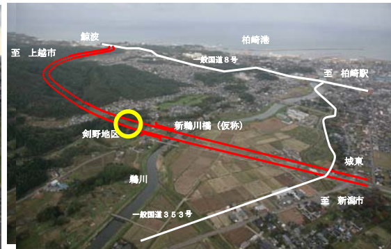
一般国道8号柏崎バイパス（新潟県） 柏崎市街地の交通渋滞の緩和と沿道環境改善を図る事業で、剣野地区の改良工事を推進します。
