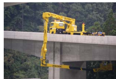
橋梁点検実施状況（写真：一般国道470号 此木ランプ橋、石川県）
