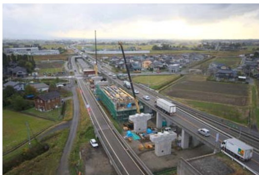
一般国道8号滑川富山バイパス（富山県） 滑川市から富山市の交通渋滞の緩和を図る事業で、有金地区の橋梁上部工事を推進します。
