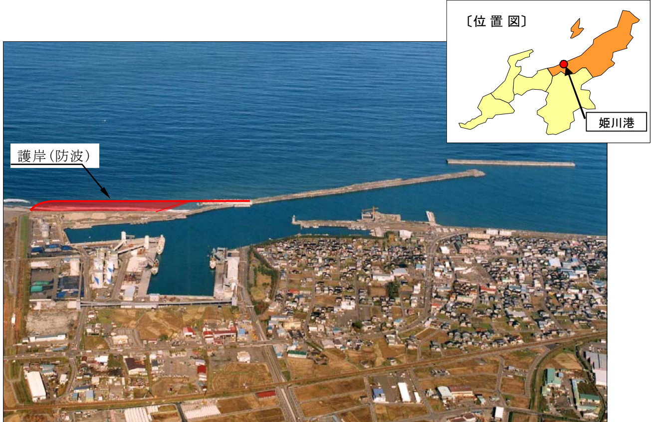
姫川港の現況
