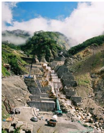
導流落差工の施工状況
