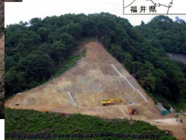
ダムサイト左岸掘削状況 H18.7.31 撮影
