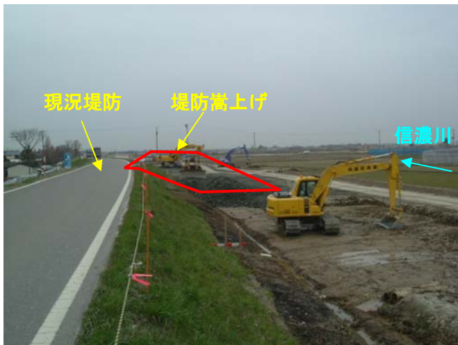
新潟市上八枚地区の築堤現場 (H18.4)
