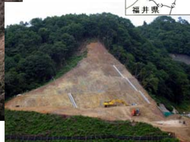
ダムサイト左岸掘削状況 H18.7.31 撮影
