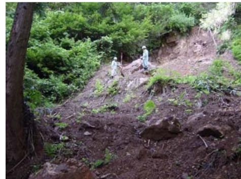
ダムサイト上流崩壊状況 (平成16年8月撮影)
