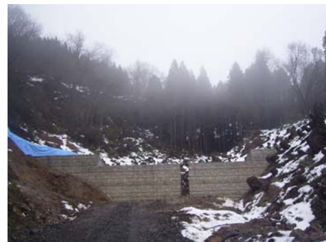
施工状況(平成18年12月撮影)
