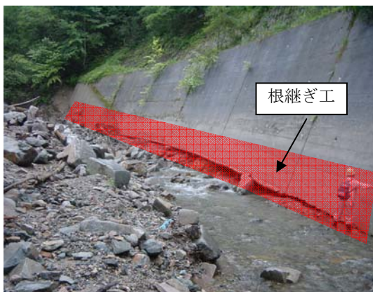
外ヶ谷第2号上流砂防えん堤護岸
