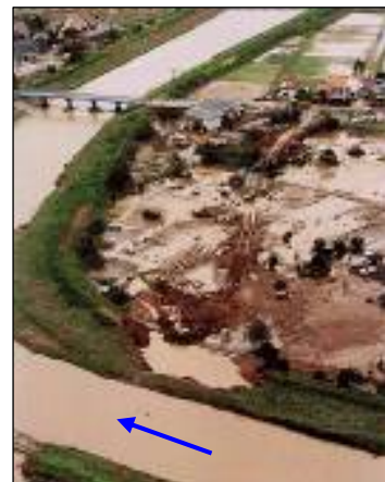
平成10年9月 動橋川破堤状況
