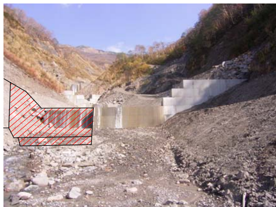
別当谷第15号えん堤（平成18年10月撮影）
