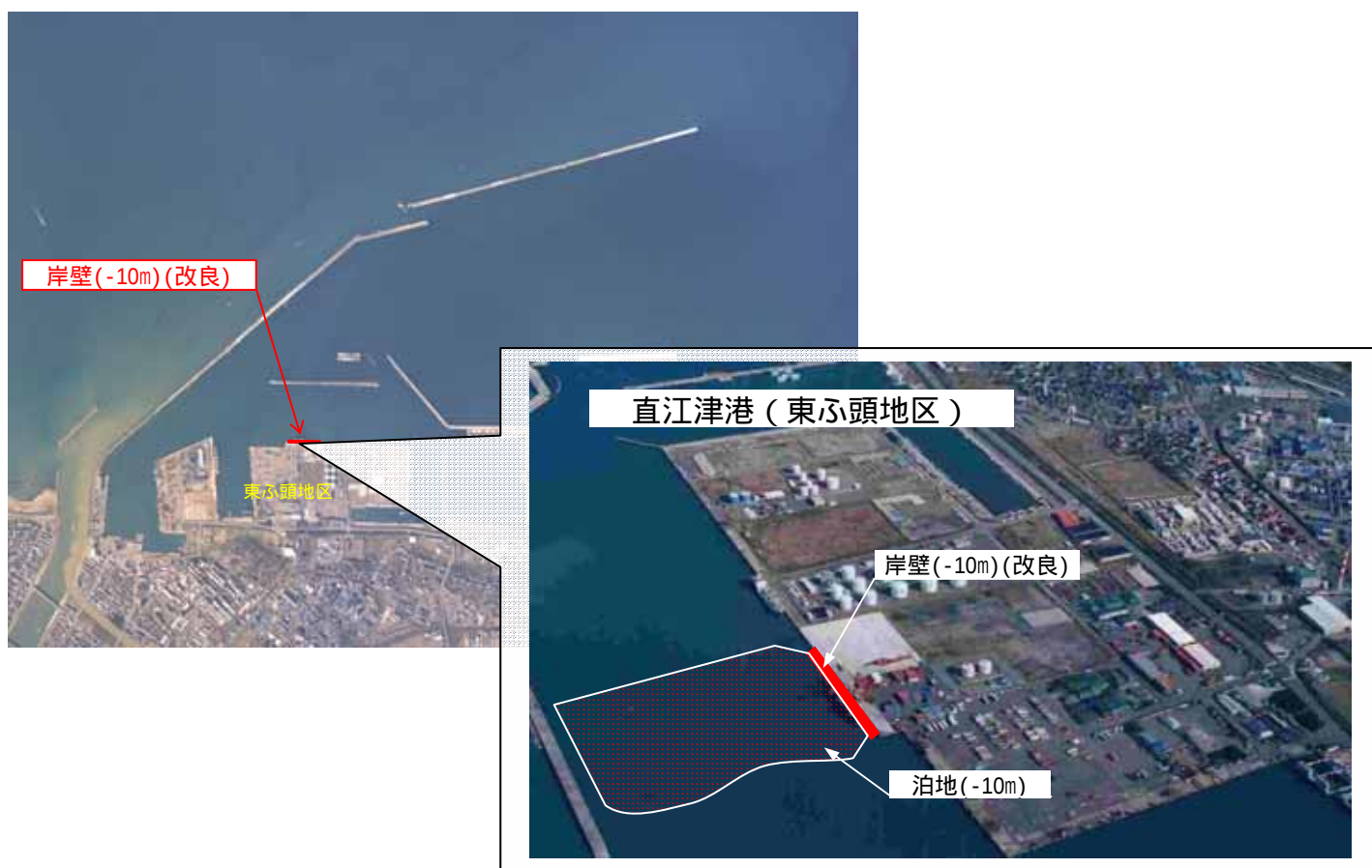
直江津港（東ふ頭地区）の現況
