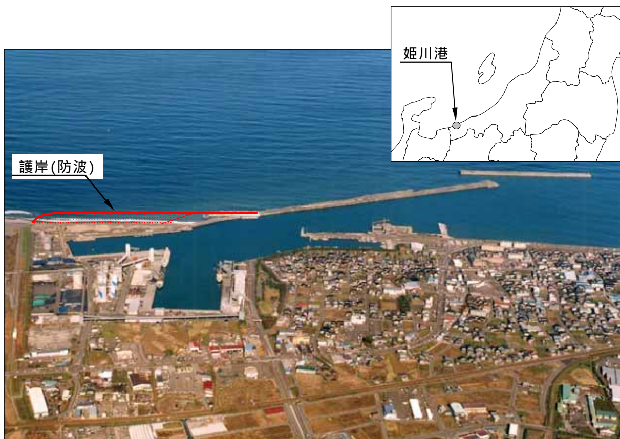
姫川港の現況（平成 13 年 10 月撮影）
