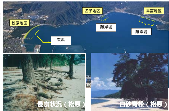
敦賀港海岸侵食対策事業（福井県）
