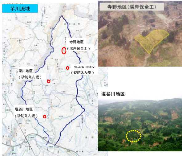
芋川河道閉塞対策工(新潟県)
