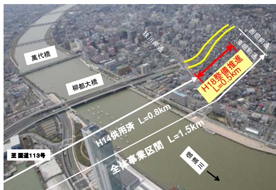
国道7号柳都大橋延伸部（新潟県）
