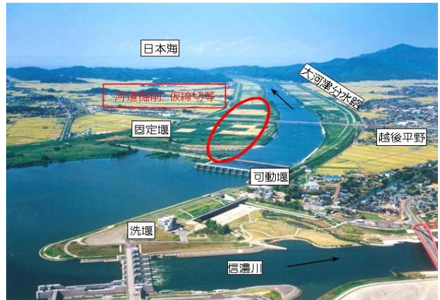
大河津可動堰改築事業(新潟県)
