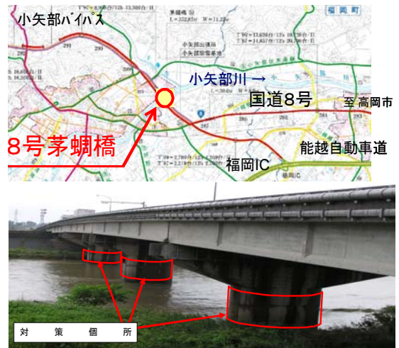
国道 8 号茅蜷橋耐震補強事業（富山県）
