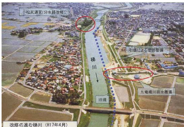
梯川重点区間改修事業（石川県）
