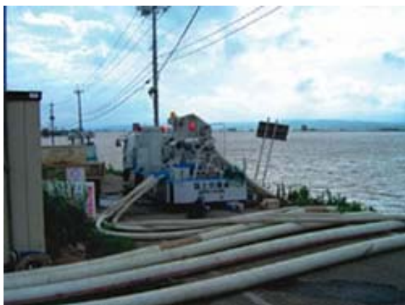
排水ポンプ車の稼働状況 < H16.7.13 水害 > (新潟県長岡市)
