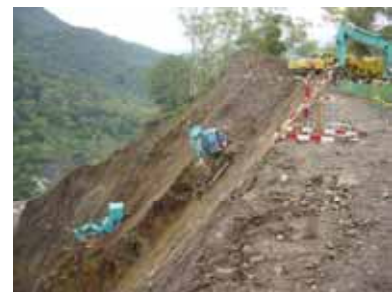
無人機械による施工状況
