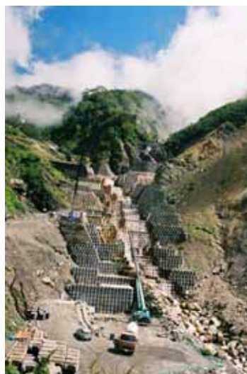
導流落差工の施工状況
