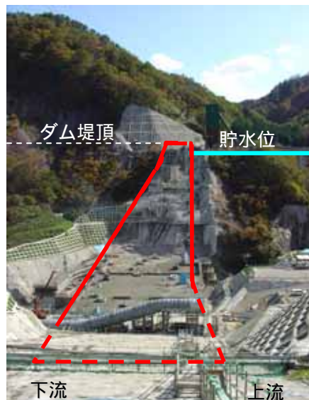
横川ダムの本体打設状況 (平成 16 年 10 月撮影)
