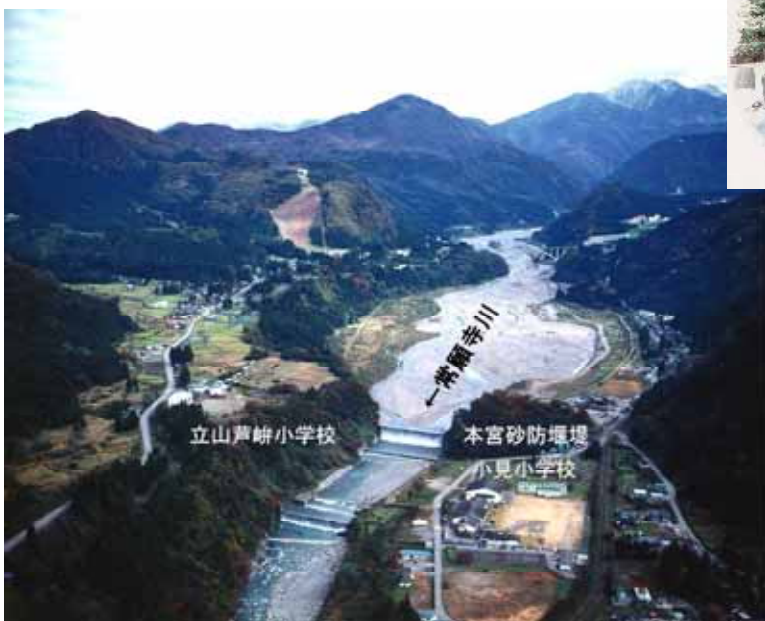
本宮砂防えん堤周辺の状況
