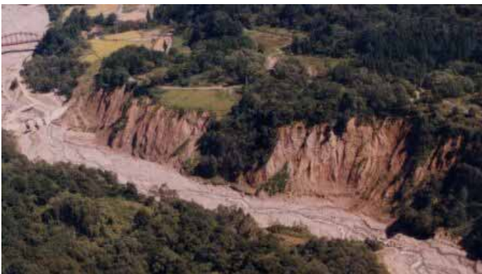
浦川の溪岸斜面の崩壊状況
