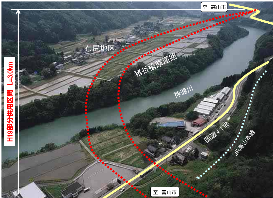
平成19年度部分供用に向け整備の進む猪谷榆原道路
