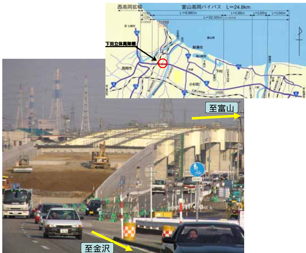
平成 17 年度完成に向け整備の進む下田立体高架橋
