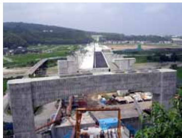
涌波トンネルから犀川方向
