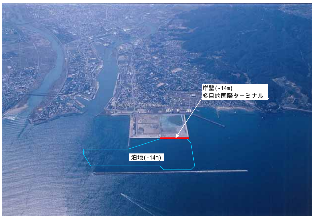
伏木富山港（伏木地区）の現況（平成16年3月撮影）
