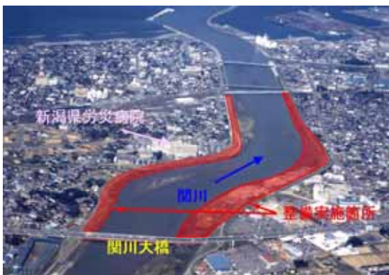
整備実施箇所
