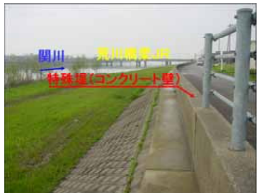
現在、特殊堤により川に近づきにくい
