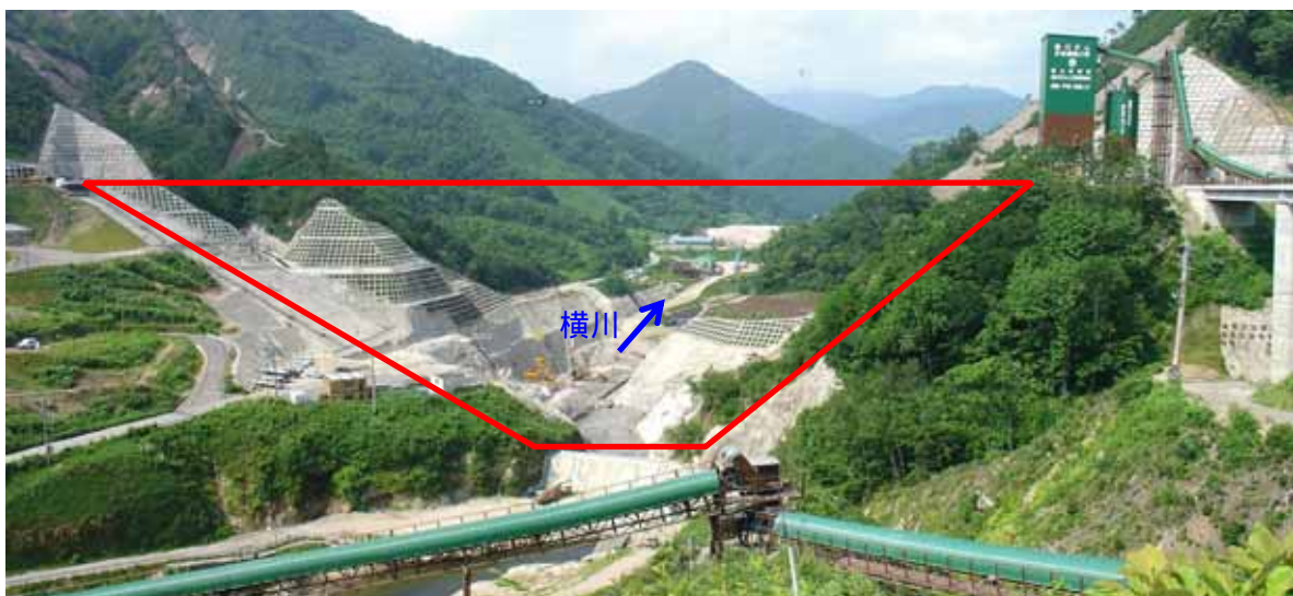
ダム本体コンクリート打設中の横川ダムサイト (上流からダムサイトを望む：平成 16 年 7 月撮影)
