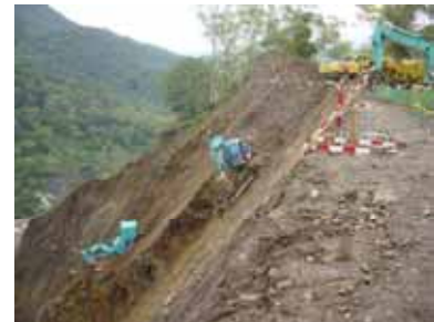
無人機械による施工状況
