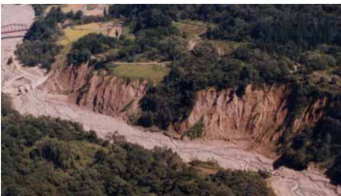
浦川の溪岸斜面の崩壊状況
