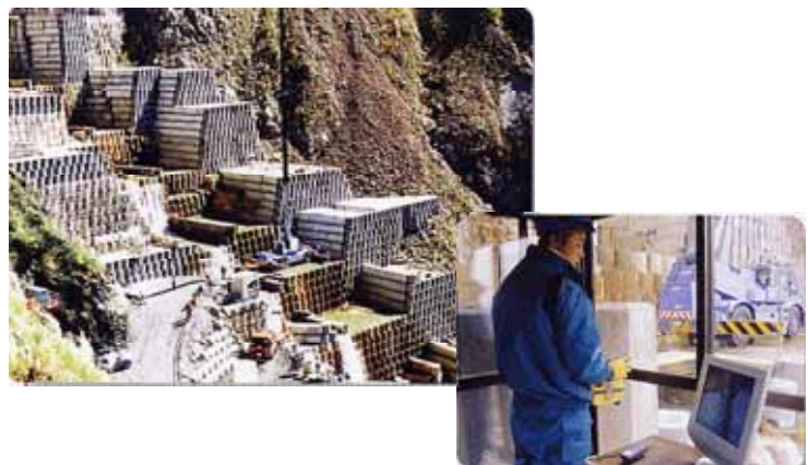
大型無人クレーンの作業状況
