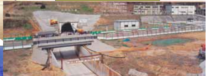
トンネル呑口部の状況写真
