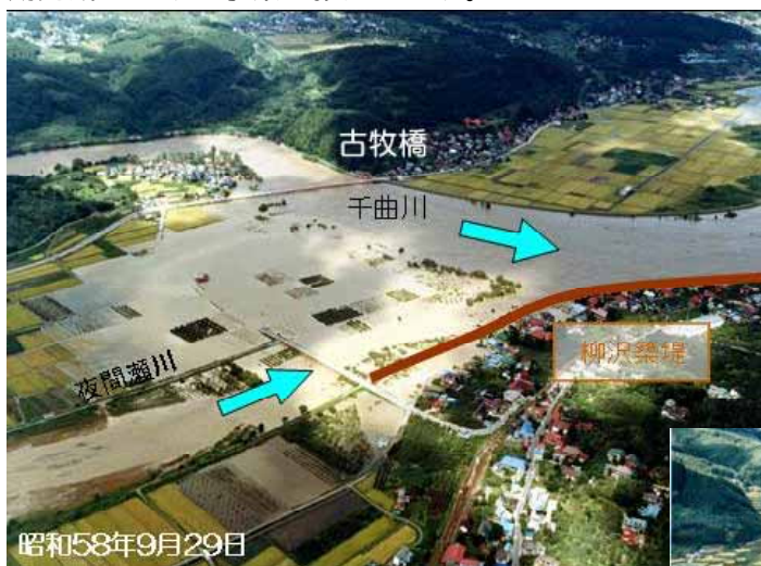
中野市 柳沢地先 S58出水 浸水状況
