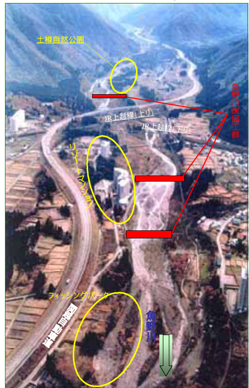
魚野川床固工群(土樽地区)
