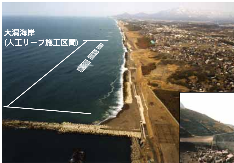
事業箇所（平成16年3月撮影）
