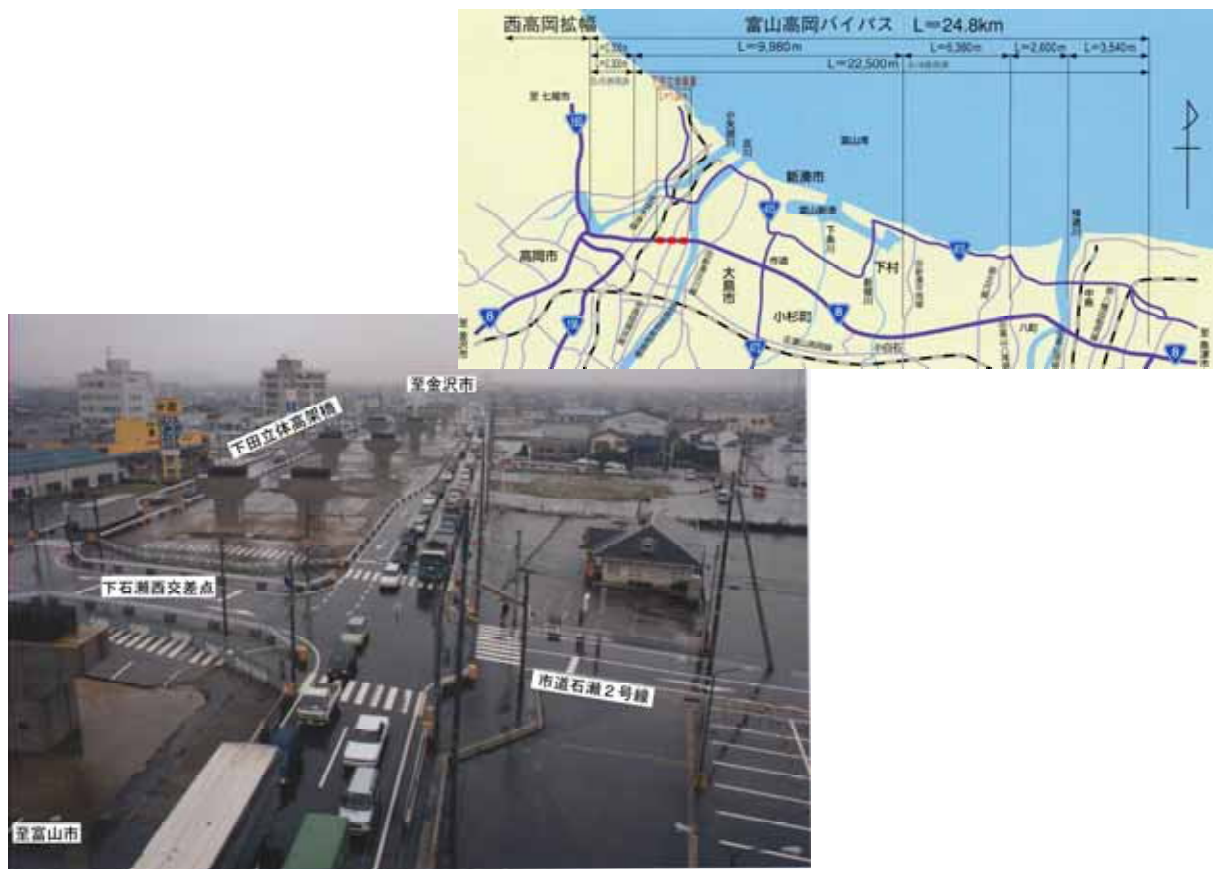
平成 17 年度完成に向け整備の進む下田立体高架橋 （富山方面から金沢方面を望む）
