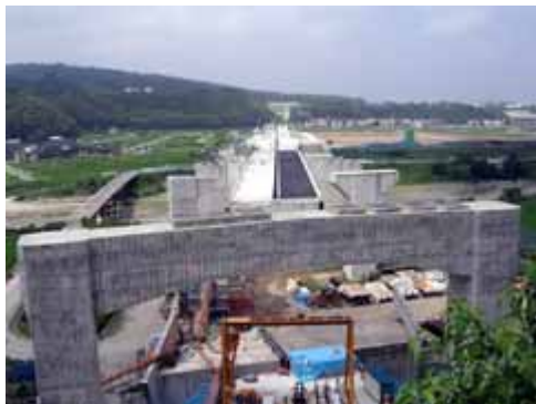
涌波トンネルから犀川方向
