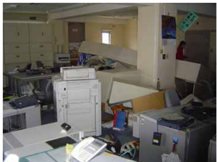
地震直後の事務室の状況
