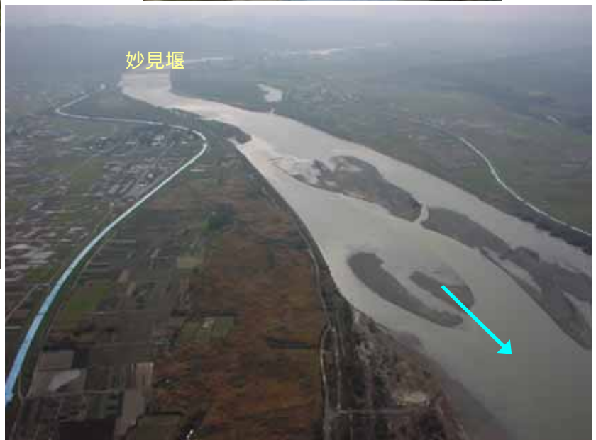
シート張りによる堤防応急対策の状況 H16.11.3 撮影
