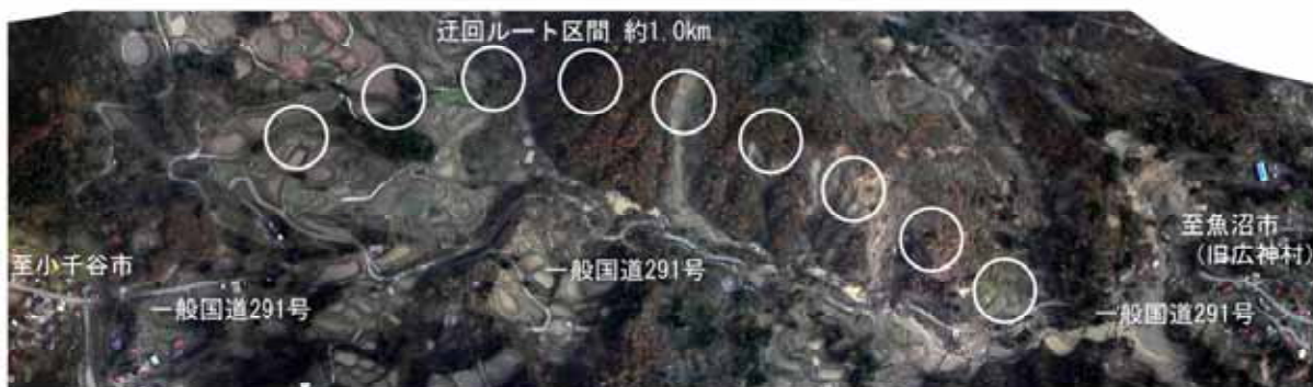
迂回ルートとして整備する区間(上空より)
