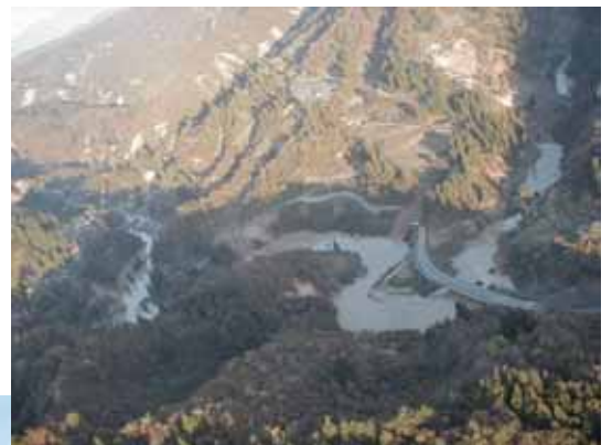
芋川（山古志村東竹沢・前沢川合流点直下流） 河道閉塞状況（H16.10.28撮影）
