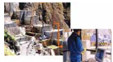
無人化施工の状況
