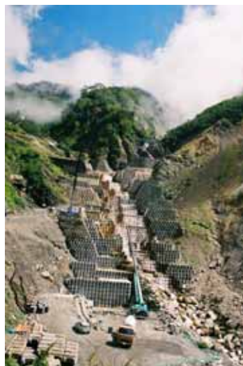
導流落差工の施工状況
