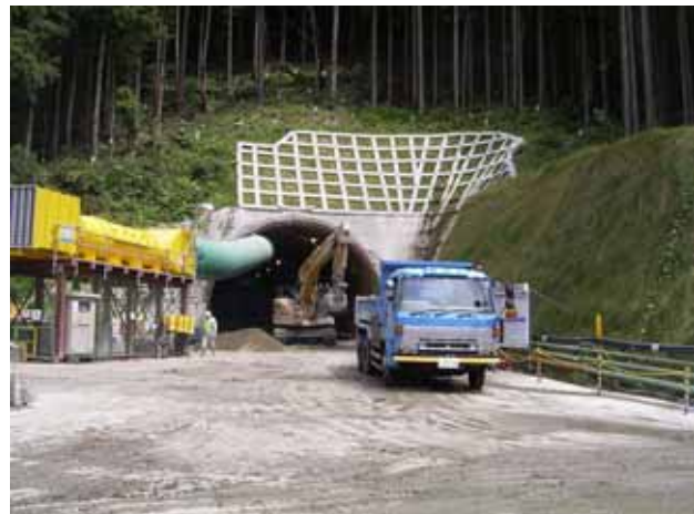
トンネル工事状況（西山町側坑口）
