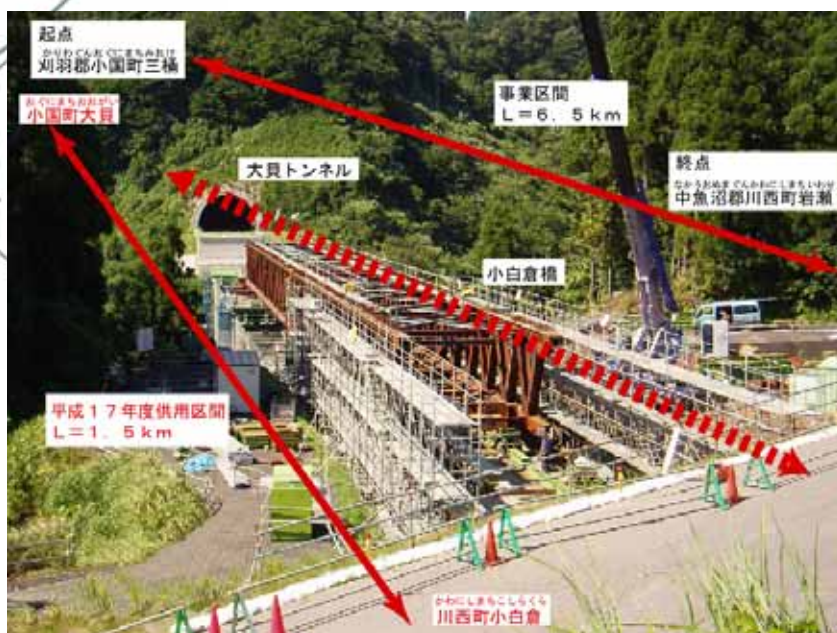
供用予定の小白倉橋と大貝トンネル
