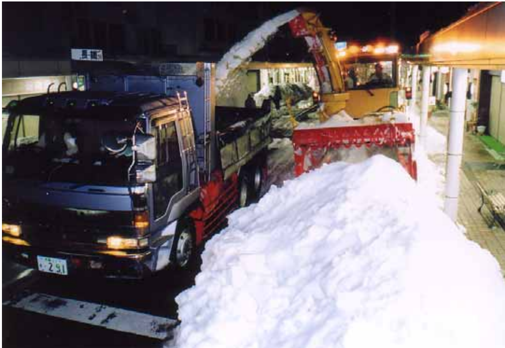
流雪溝の機能低下により路側に堆雪した雪を処理（小千谷市内）
