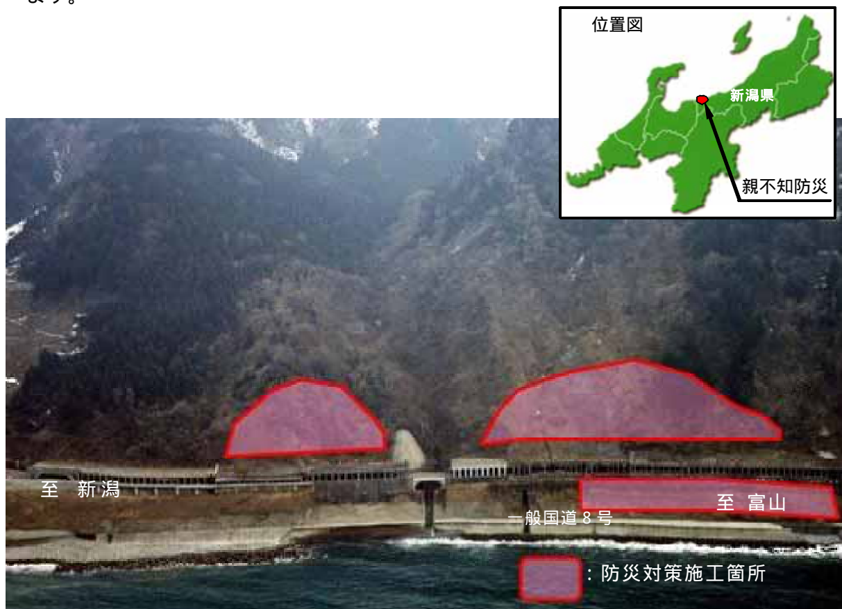
規制緩和に向けた防災対策施工箇所 （青海町三段滝地先）
