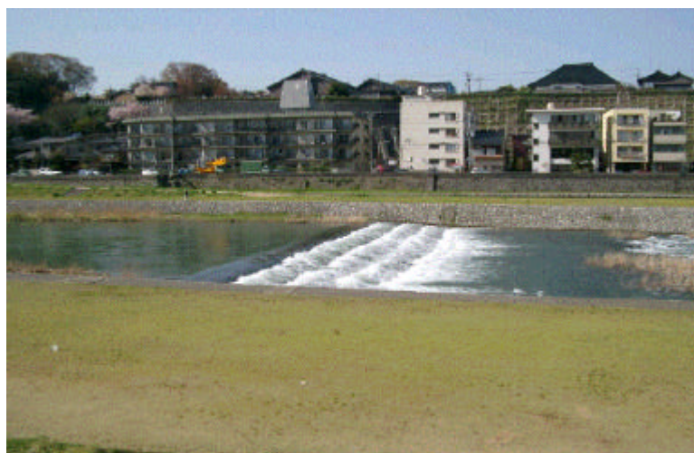
金沢市中川除町地先の落差工改良状況（平成15年4月撮影）
