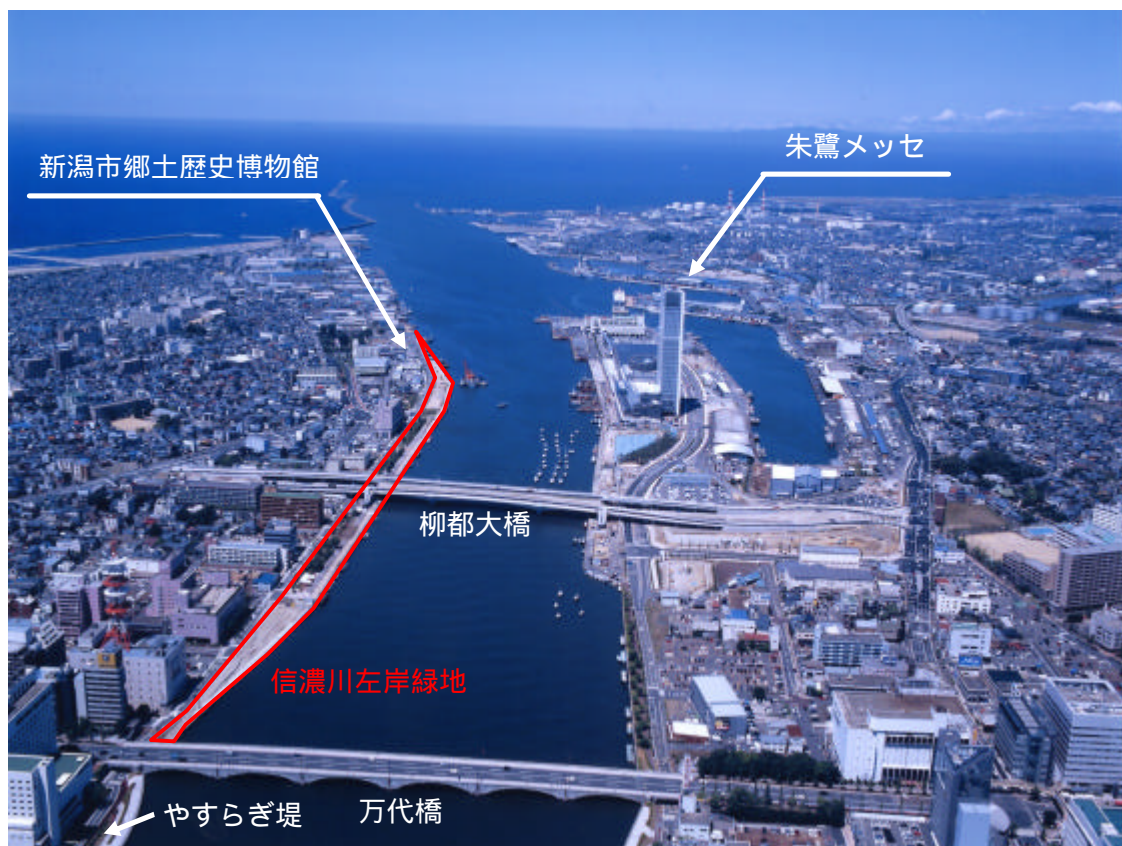
信濃川左岸緑地周辺の現況（平成 14 年 10 月撮影）
