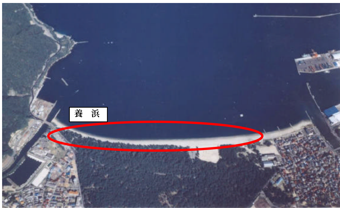
敦賀港海岸（松原地区）の現況
