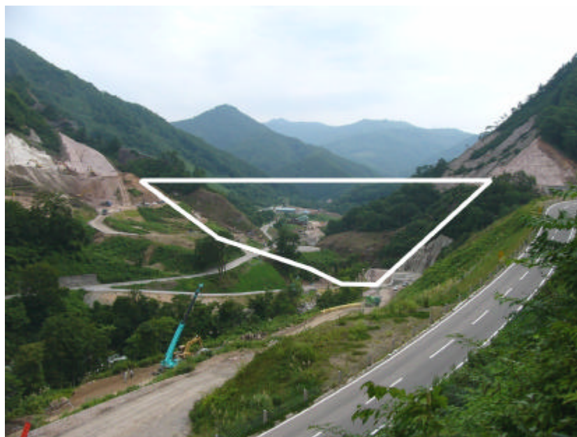
ダムサイトを上流より望む
