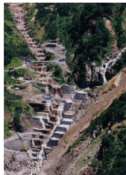
柳谷上流砂防えん堤群
