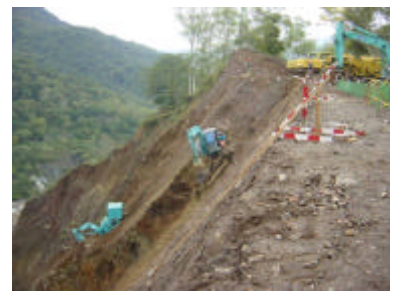
無人機械による施工状況
