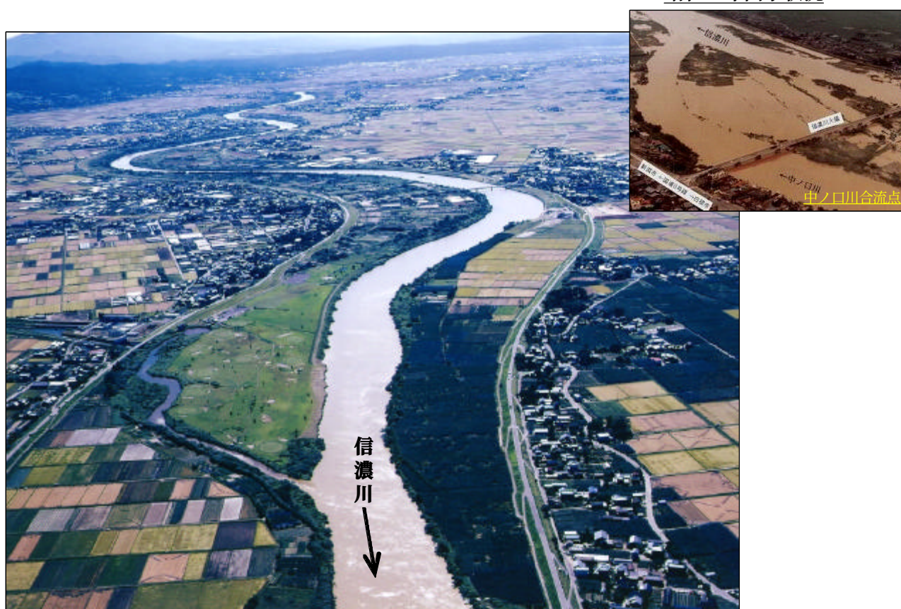
昭和53年出水状況
