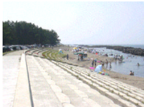
施工後 平成15年8月)
