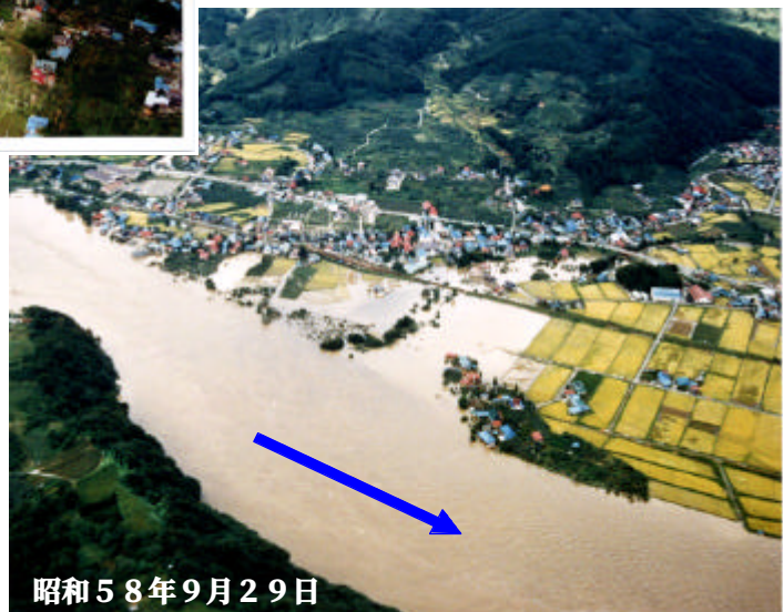
豊田村 替佐地先 S58出水 浸水状況
