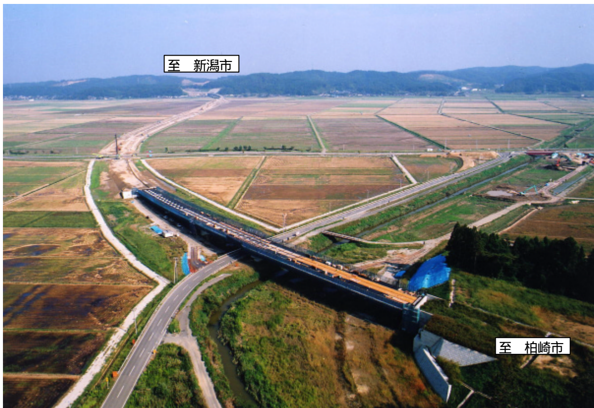
平成15年度供用に向け工事の進む和島バイパス (柏崎方向から新潟方向を望む)
