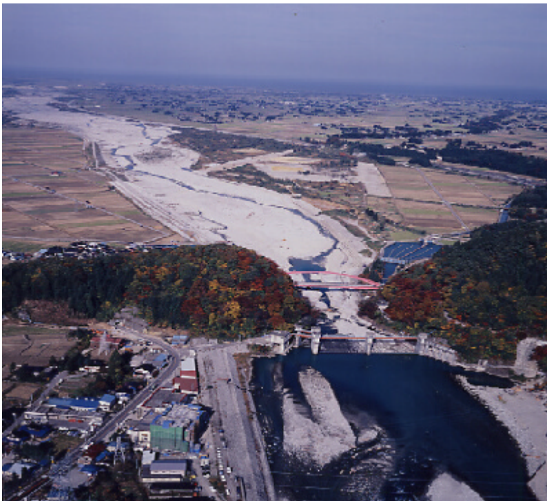
愛本堰堤下流の黒部川の状況
