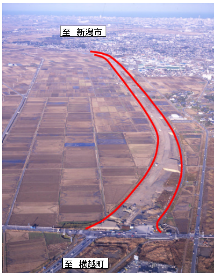
平成15年度供用に向け工事の進む横雲バイパス (横越方向から新潟方向を望む)
