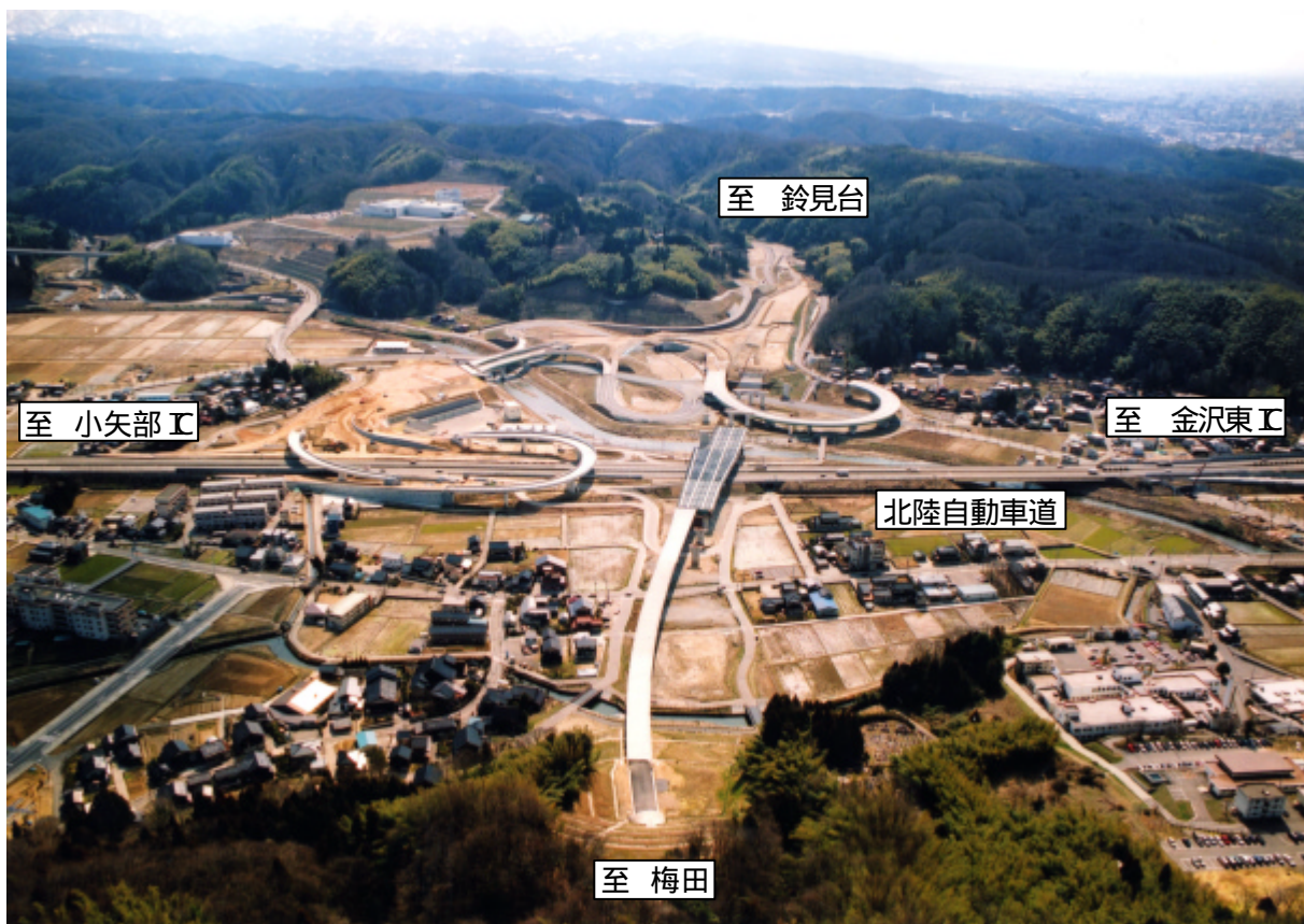
平成 1 5 年度供用に向け工事の進む月浦 I C (仮称) 付近 (梅田方向から鈴見台方向を望む)
