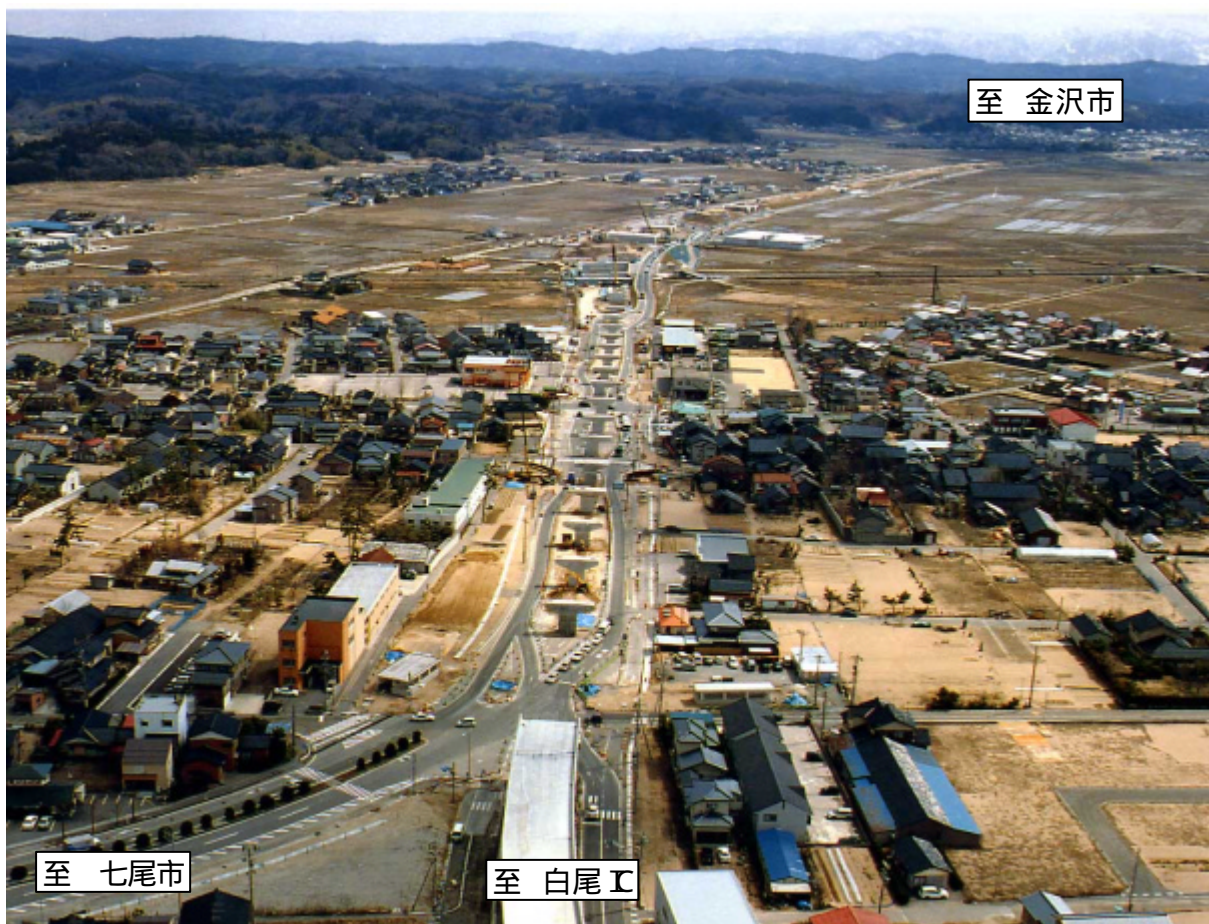
平成15年度供用に向け工事の進む津幡バイパス (白尾方向から金沢方向を望む)
