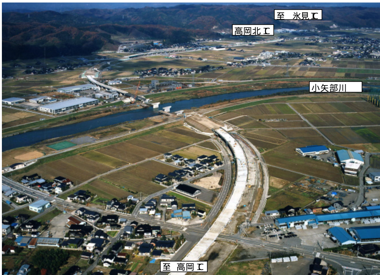
平成15年度供用に向け工事の進む高岡砺波道路 (高岡IC方向から高岡北IC方向を望む)
