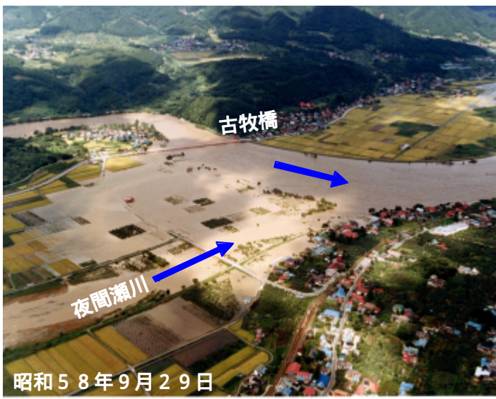
中野市 柳沢地区 S58出水 浸水状況
