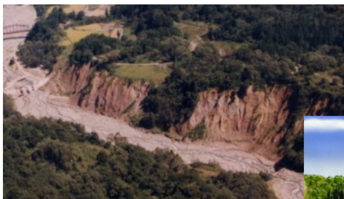
浦川の溪岸斜面の崩壊状況
