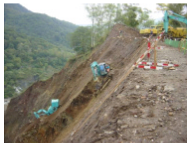
無人機械による施工状況
