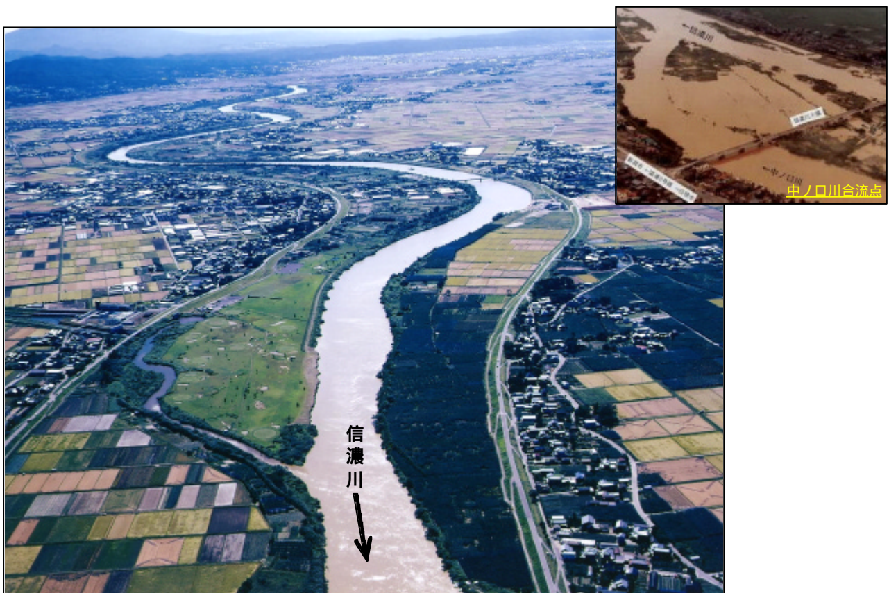
昭和53年出水状況
