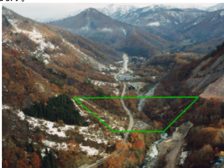
本体施工箇所付近（上流側より望む H14.11 撮影）
