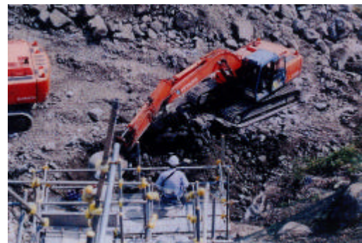
遠隔操作による掘削状況
