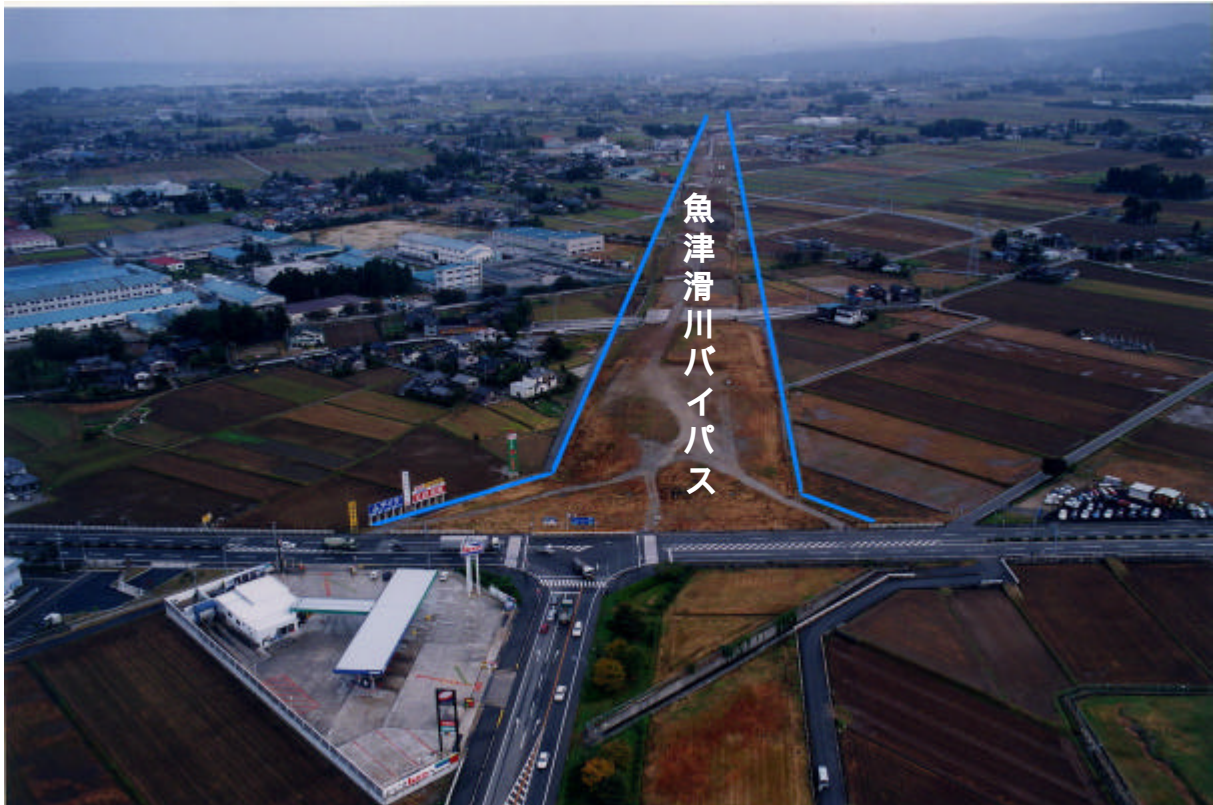
魚津滑川バイパス整備状況 ( 終点から起点方向を望む )
