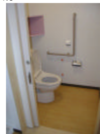
手すりの設置
