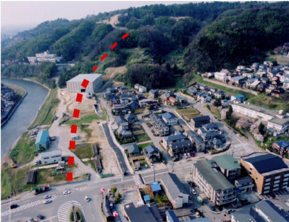
金沢東部環状道路 (鈴見地区から御所 IC 方向を望む)
