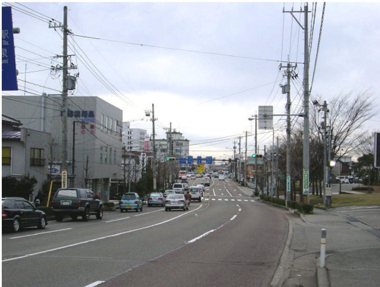
地中化事業を整備する一般国道157号金沢市横川地区
