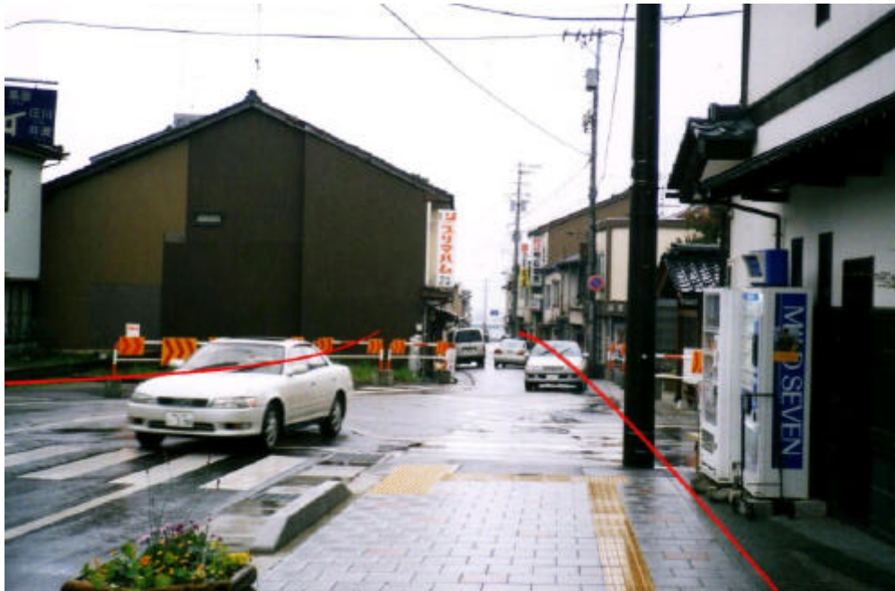
供用済区間より出丸地区を望む
