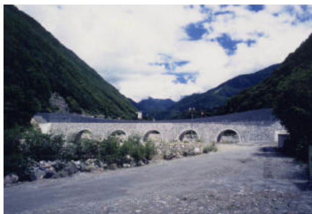
地獄平砂防えん堤（下流より撮影）
