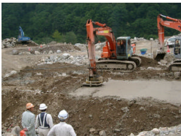
砂礫とセメントミルクの攪拌状況
