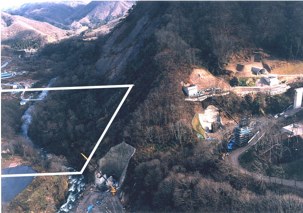
工事用道路現況写真（無沢橋梁施工現況、H13.11撮影）
