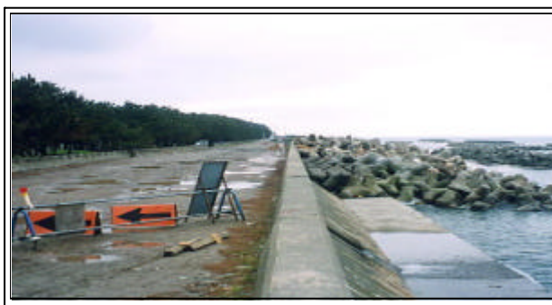
整備前：直立堤により海岸へのアクセスが出来ない。
