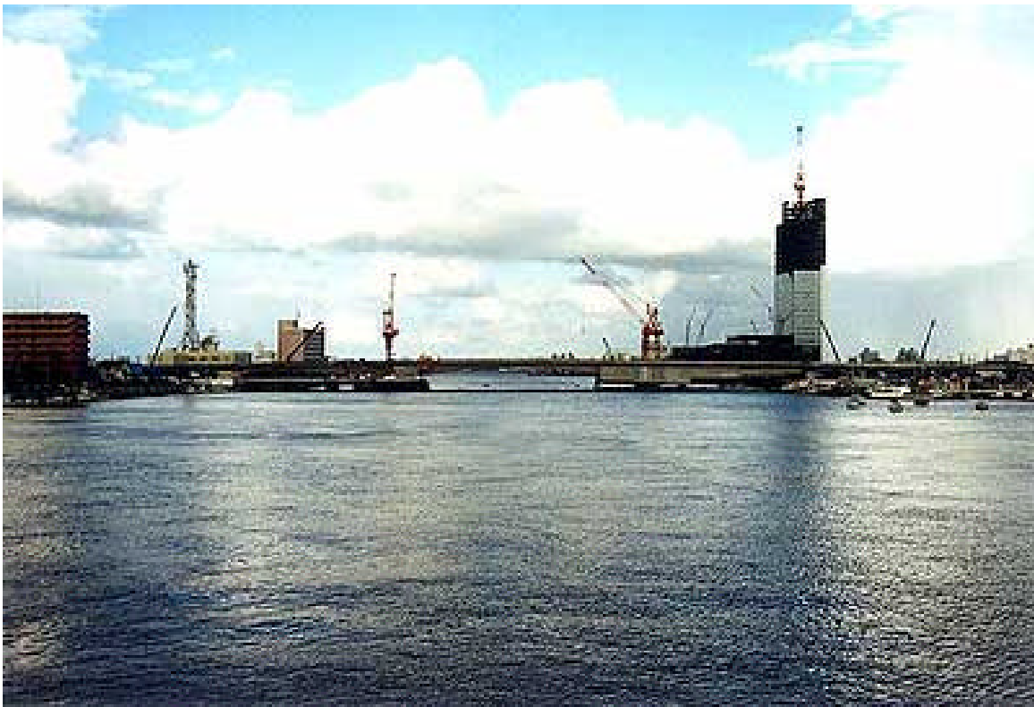
－12月21日に連結式を終え、5月の供用に向け工事推進中の柳都大橋－
