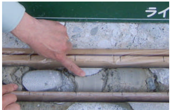
図-21 一次注入剤の充填状況
