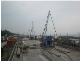
図-6 ボーリング調査
