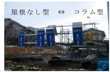
写真-5 標識模型設置状況
