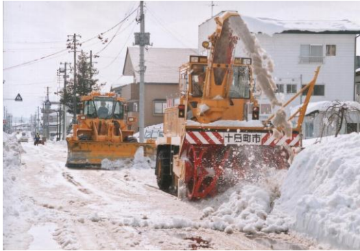
写真-3 除雪機械による作業風景
