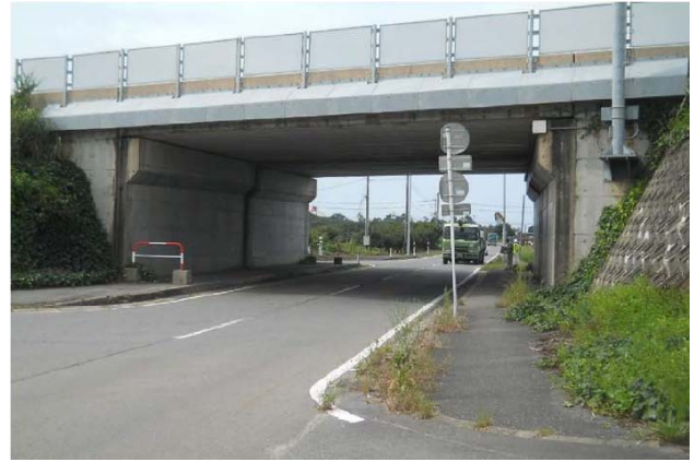
写真-1 現況の大夫興野 I C 橋
