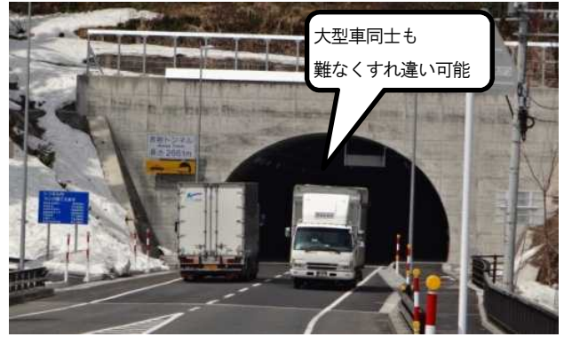
図7 開通後のすれ違い状況 (赤岩トンネル) (2013.4)
