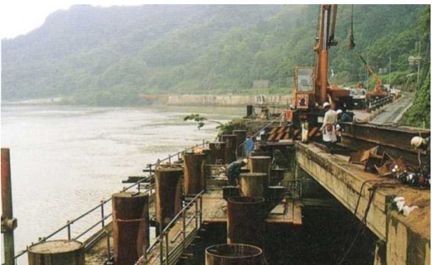
図-2 阿賀野川側への道路拡幅工事
