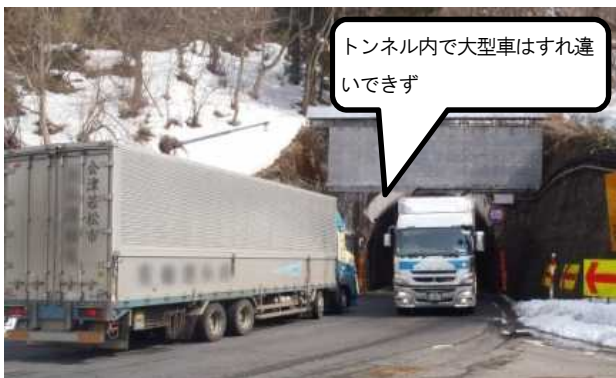
図6 開通前のすれ違い状況 (揚川トンネル) (2013.3)
