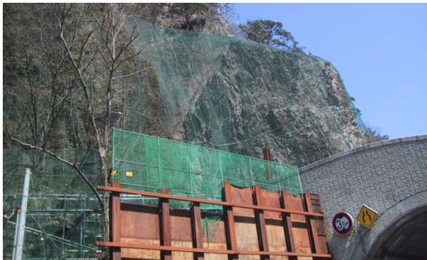
図-1 落石防止のための法面対策
