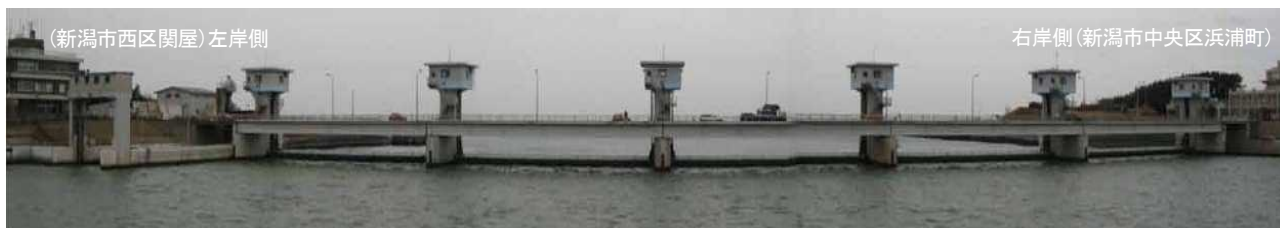
写真-2 新潟大堰全景(上流側より望む)
