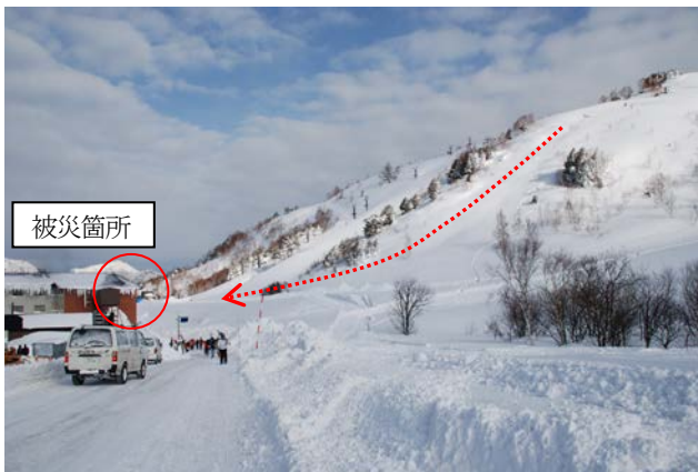
写真-3 志賀高原前山災害現場全景(2月8日撮影)
