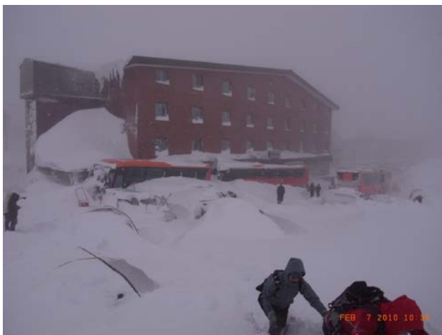
写真-4 志賀高原前山災害現場の状況(2月7日撮影)
