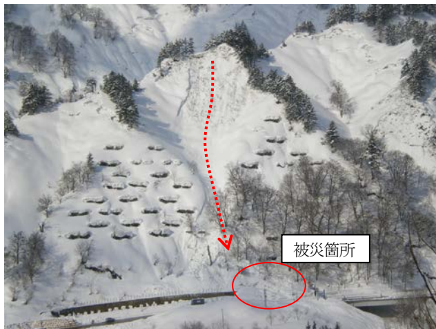
写真-7 月山道路災害現場全景
