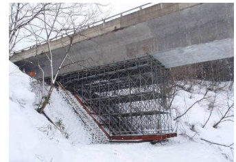
写真8 ステーキング設置
