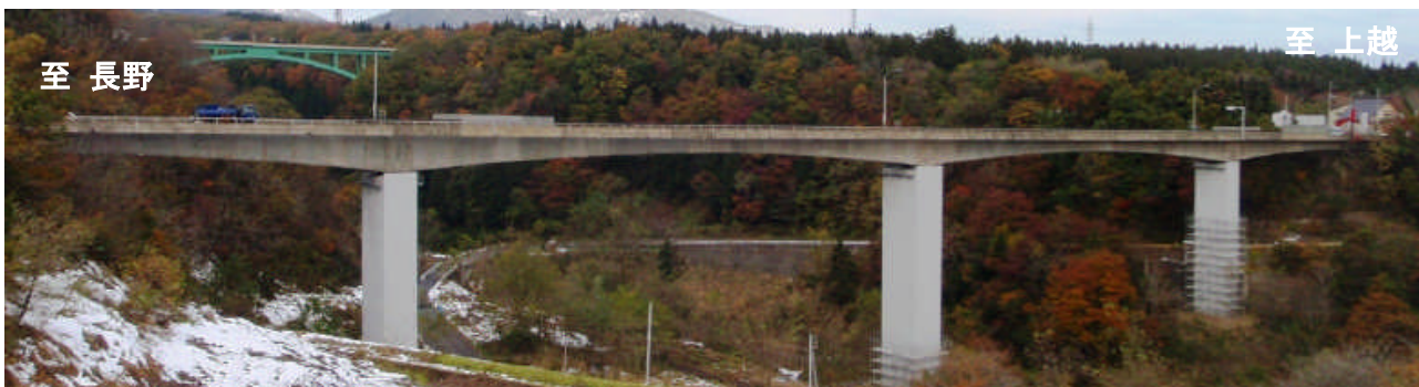
写真1 妙高大橋全景
