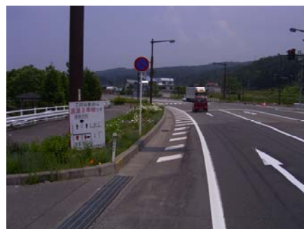
図6: 案内看板設置状況
