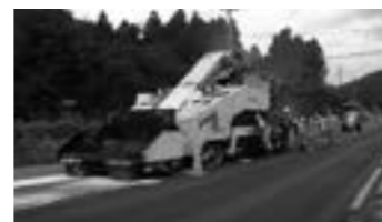
MAP工法を用いた舗設状況▶P.13
