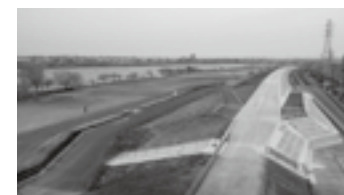
平井高潮堤防工事(関東地整)▶P.19
