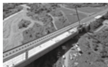
橋梁床板の取替▶P.9
