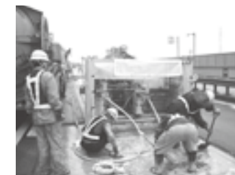
WJ施工状況▶P.13
