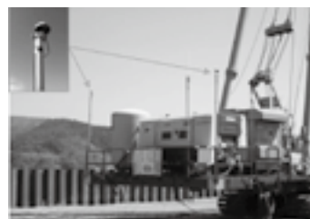
GNSS受信機設置状況 ▶P.15
