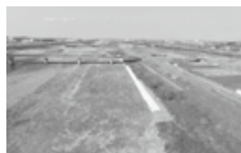
工事完成写真 (平成31年3月1日撮影) ▶P.11
