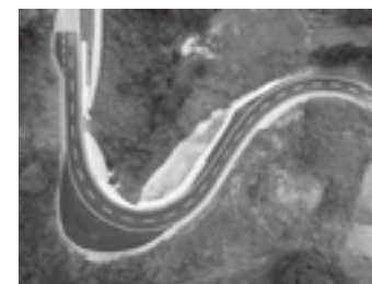
平成29年度 新潟県優良工事表彰 「一般国道403号防大雪災害 (内地国道・凍雪害) 道路改良工事」▶P.21
