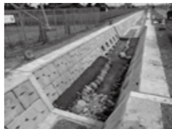
魚巢施工完了▶P.9
