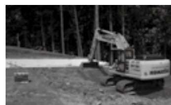
マシンガイダンスバックホウ 法面整形状況▶P.5
