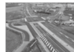
国道 舗装工事
